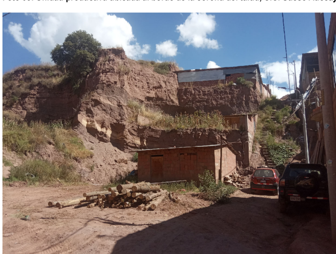
Foto 06: Viviendas precarias ubicadas en zona de talud escarpado, APV, Villa los Arenales.
