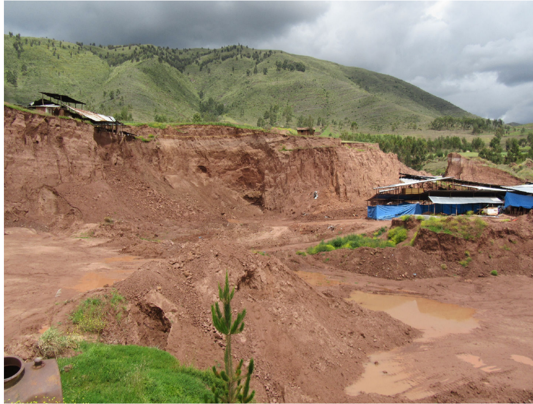
Foto 01: Talud escarpado junto a las Unidades productivas ubicadas, C.C.Picol Orcompuco.
