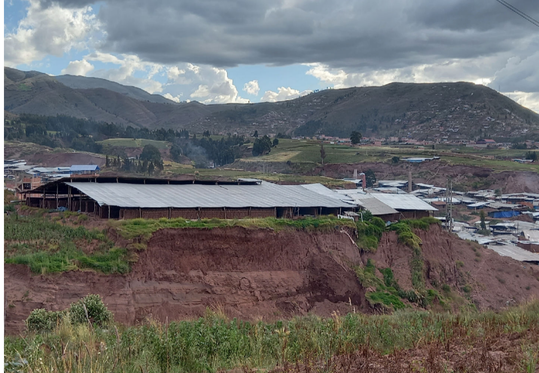
Foto 05: Unidad productiva ubicada al borde de la corona del talud, C.C. Susco Aucaylla.
